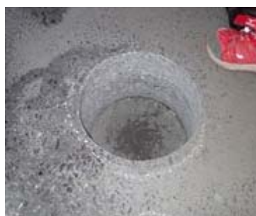
コア採取坑の状況 (非早期劣化箇所)
