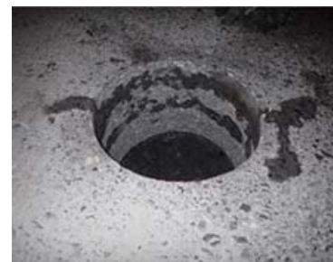
採取直後のコア採取坑の状況 (早期劣化区間)
