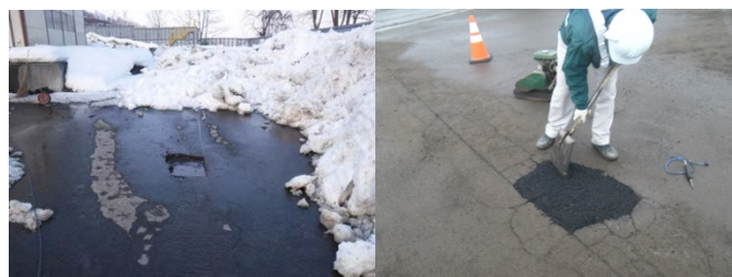
写真-1 施工箇所
