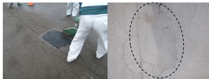
写真-3 転圧状況
