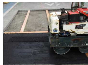
写真-1 施工状況 (転圧)
