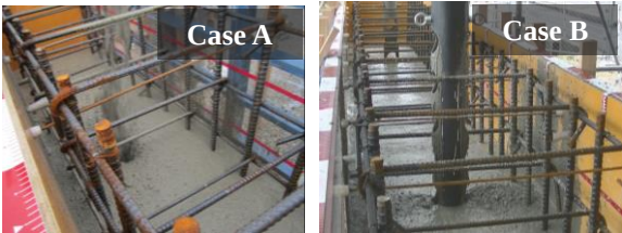
写真-1 打込み状況
