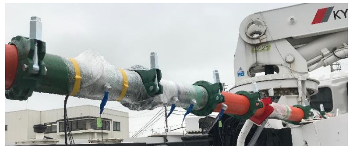
写真-1 圧力計, 振動加速度計設置状況
