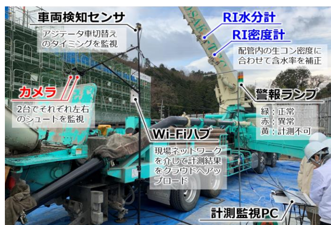
図-3 単位水量とスランプの全数計測状況
