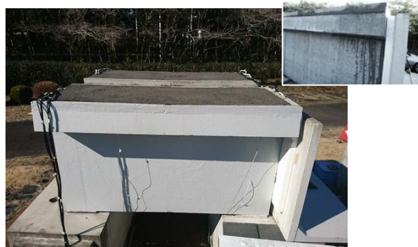
図-2 桁供試体の外観と降雨後の水濡れ状況
