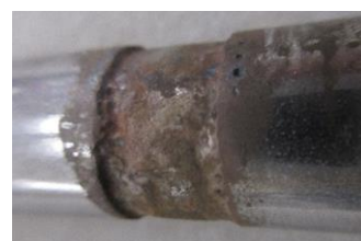
図-2 電食後の供試体の様子(腐食部)
