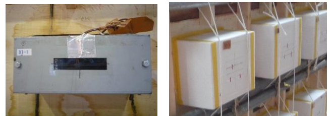
図-2 サーモラベルの貼付けおよび養生箱設置
