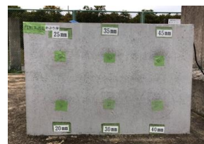
写真-2 損傷箇所
