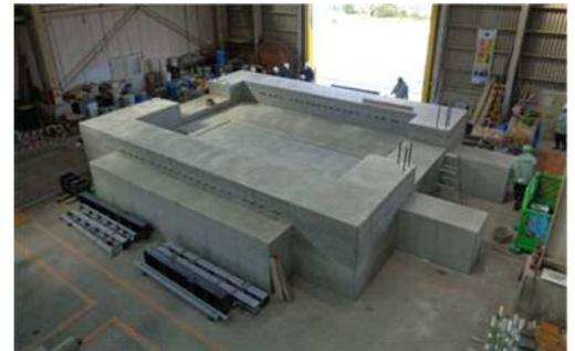
写真-1 床版製作架台
