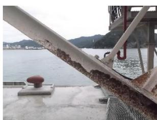
図1 塩害を受けた熔融亜鉛めっきのアンクル
