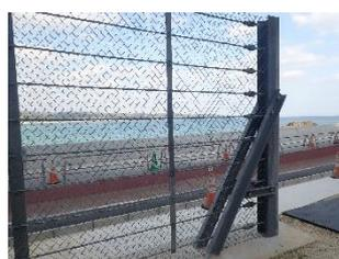
図2 熔融亜鉛アルミニウム合金めっきの防護柵
