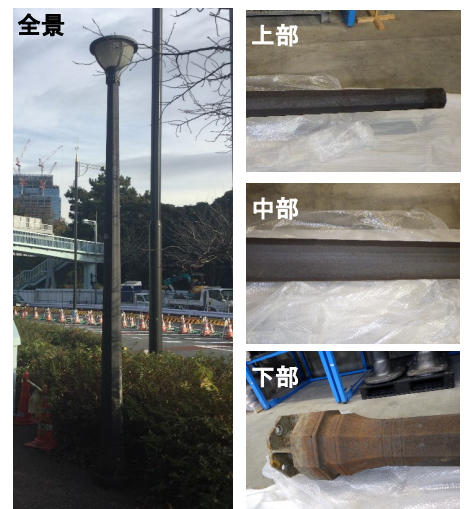
図-1 調査対象照明柱の外観
