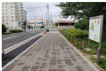
写真-2 保水性ブロック舗装
