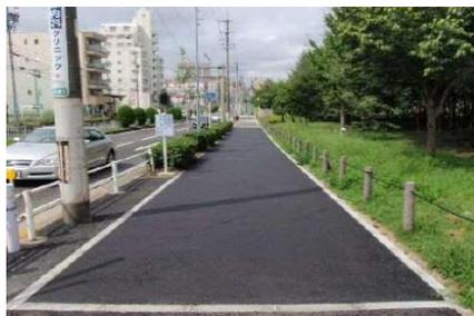
写真-1 保水性アスファルト舗装
