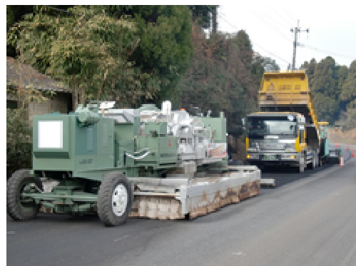
写真-1 路上表層再生工法の施工実績
