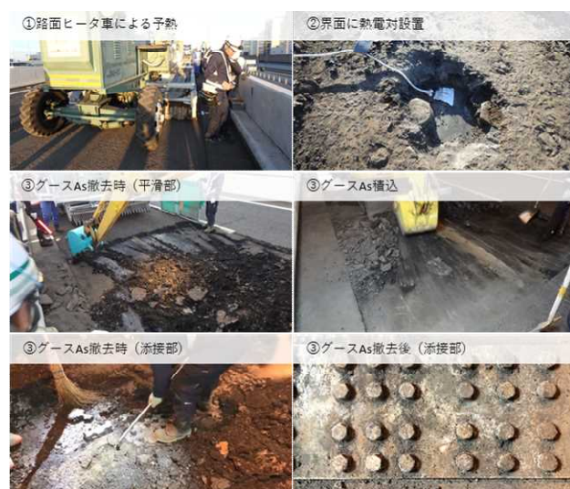
写真-2 試験施工時の様子及び試験結果
