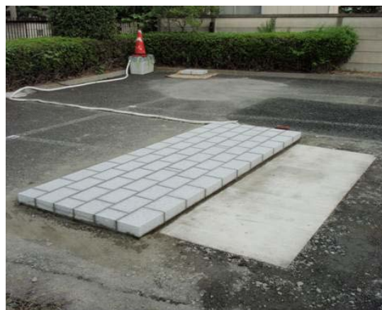
写真-1 実寸大モデルの設置状況
