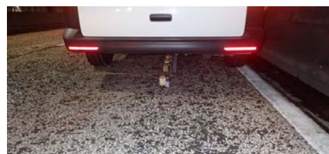
写真-2 FWD 調査状況
