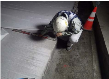
写真 - 2 下がり測定状況
