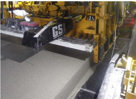
写真 - 1 施工状況
