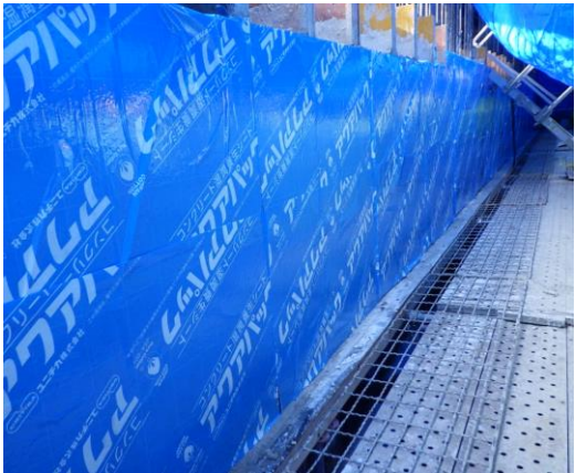
写真-1 給水型コンクリート養生シート
