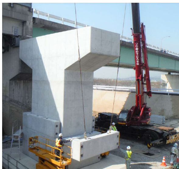
写真 1 プレキャスト鞘管施工状況
