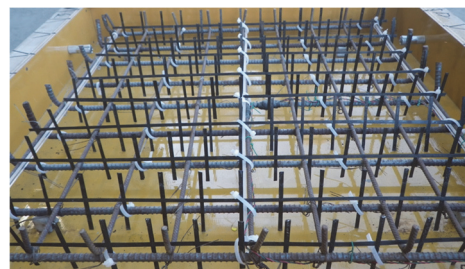
図-3 供試体の配筋とグリッドの設置状況
