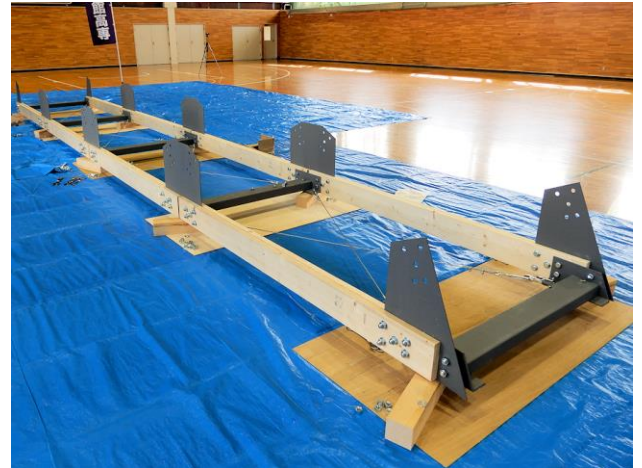
写真-6 下弦材の設置
