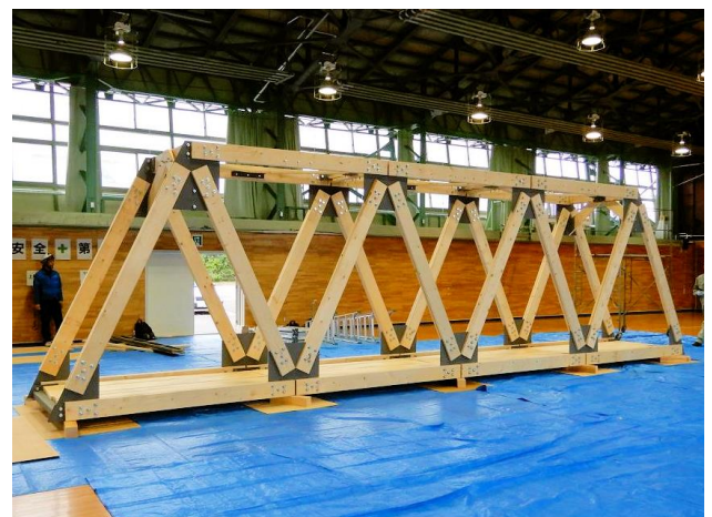
写真-8 組立完了
