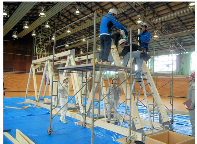
写真-7 斜材・上弦材の連結
