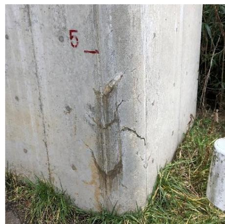
写真-1 ASR発生構造物の状況
