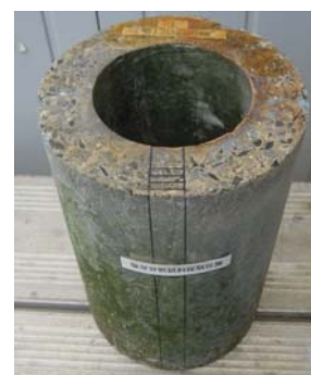
写真 2 試験体外観（暴露 10 年時）
