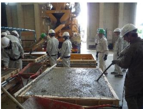
図-1 打込みの様子
