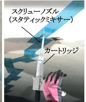
写真-2 手動式低圧樹脂注入工法(シールテープインジェクション工法)
