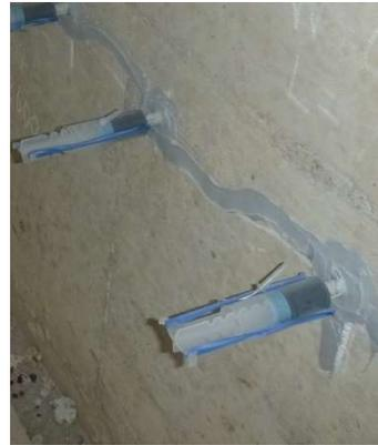
写真-1 自動式低圧樹脂注入工法
