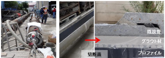
写真-1 模擬管きょ試験
