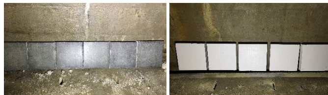
図-2 屋外暴露の状況
