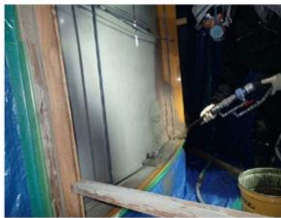
図-3 サブタンクの試験施工
