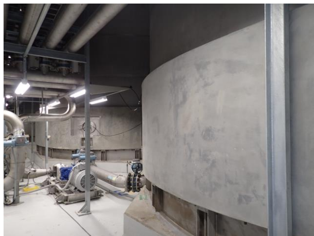
図-6 施工完了状況
