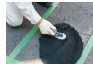
写真-3 敷均し状況
