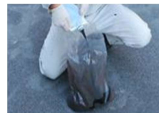
写真-2 混練状況
