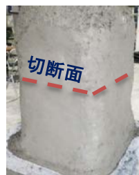
写真-4 内殻構造柱
