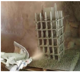
写真-1 吹付け状況
