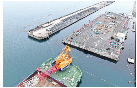
写真-4 メガフロート移設状況
