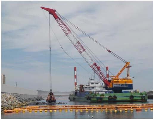
写真-2 起重機船による材料投入
