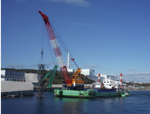
写真-3 起重機船による重錘均し状況
