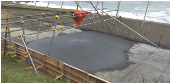
写真-1 打設後の状況（1台目 5m³終了時）
