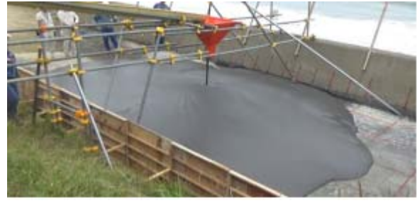
写真-2 打設後の状況（2台目 10m³終了時）
