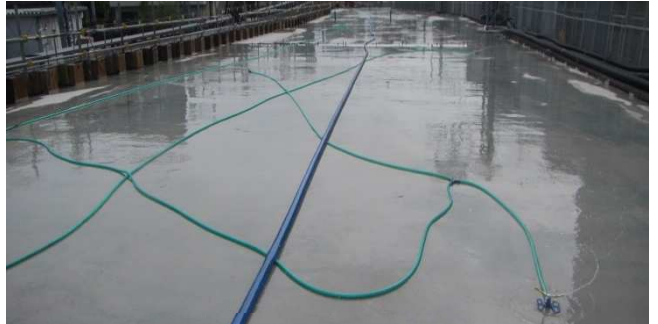
写真-3 実施工での養生状況
