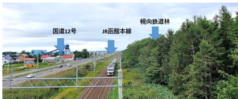
図 1 JR 函館本線 幌向・上幌向間における鉄道林・JR 函館本線・国道 12 号の位置関係 (2019 年 9 月 16 日撮影)
