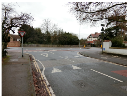
図5 進入口近くのハンプの設置
