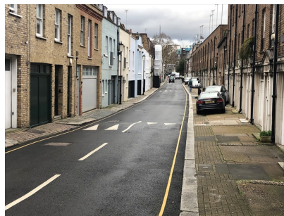
図6 幹線につながる道路での連続的なハンプの設置
