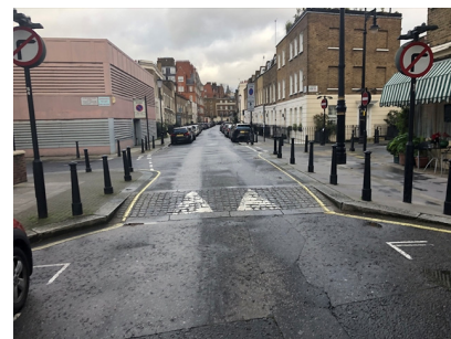
図9 エリア内の路面の高さの変化
