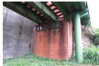
図-7 柳瀬川橋梁橋台
