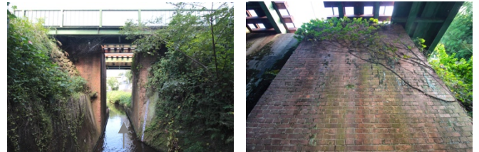
図-1 西武池袋線・立野川橋梁の現状(現・下り線橋台)
