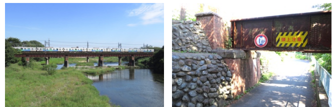
図-5 旧・入間川橋梁(左:橋梁全景, 右:左岸橋台)
