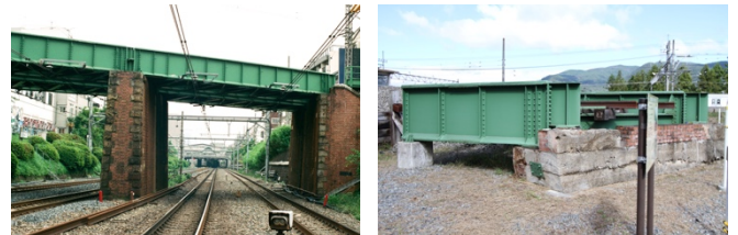
図-4 旧・山手跨線橋(左:2003年当時, 右:移築保存状況)
