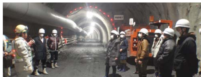
図-4 ファムツアーの様子(道路トンネル建設現場)
