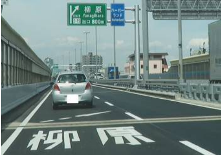
写真-4 車線別方面案内
