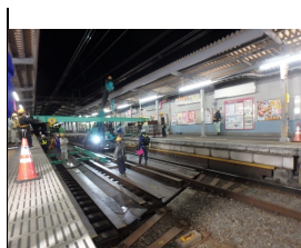
写真 2 吊桁架設状況
