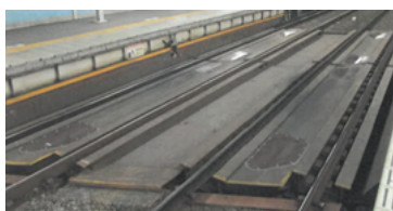
写真1 槽状桁全景
