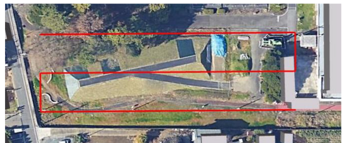
図1. 不具合を再現した堤防（赤線は撮影ルートを示す）
