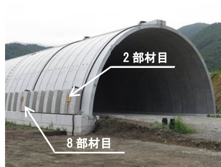
写真-1 計測を行った3 ヒンジアーチ
