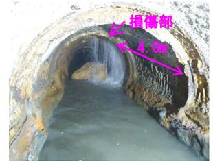
写真-1 管損傷状況
