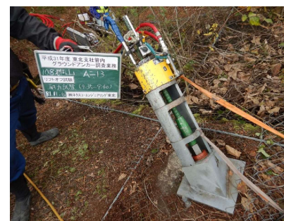
図-3 アンカー耐力試験状況
