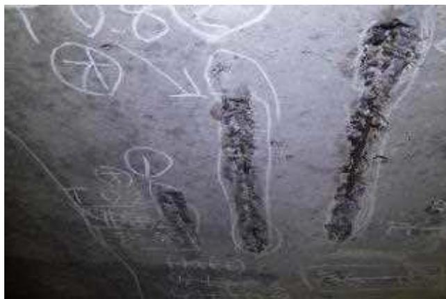
図-3 鉄筋腐食による変状の発生状況
