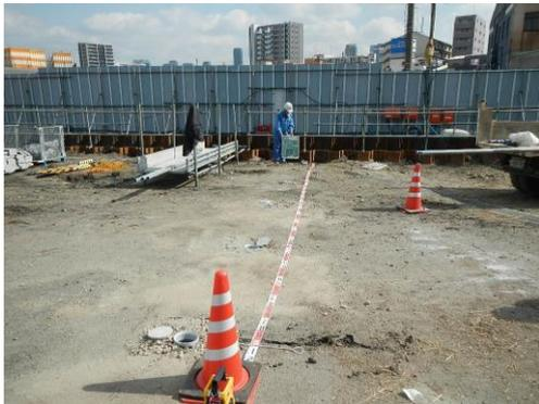
写真-1 沈下盤設置状況
