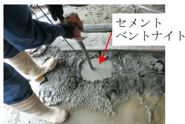
写真-2 セメントベントナイトの充填状況
