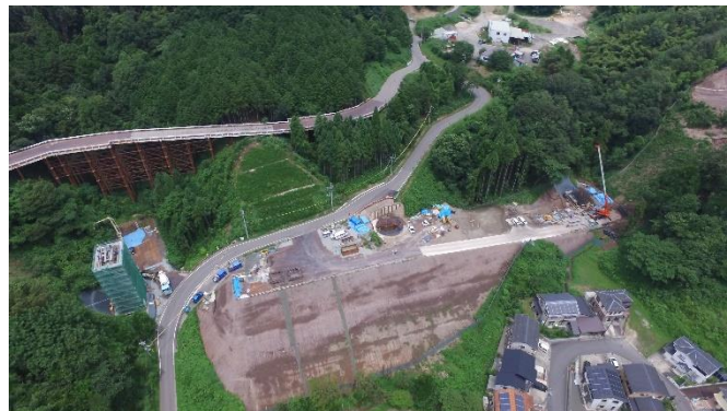
写真-1 現場状況
