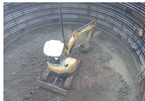
写真-2 モルタル吹付状況
