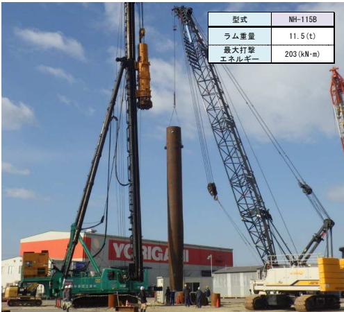
写真-1 テーパー杭打設状況
