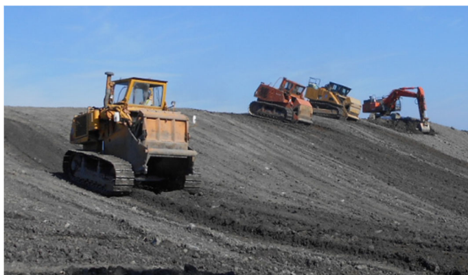
写真－2 施工状況
